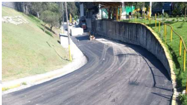
Ilustración 1. Rehabilitación de Vías internas ETN
