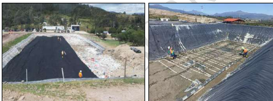
Ilustración 13. Vaciado de las piscinas Nro. 8 y 10
