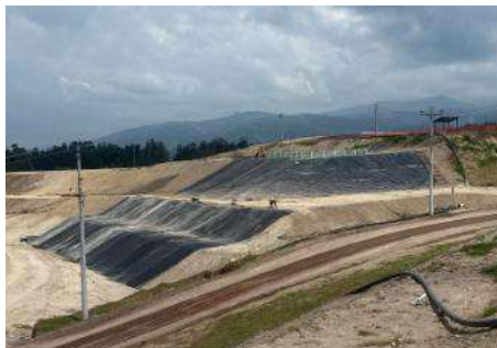
Ilustración 6. Instalación de geomembrana
