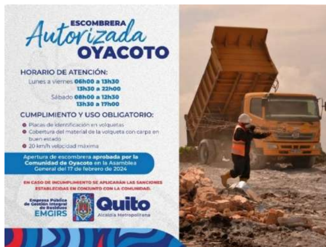
Ilustración 15. Apertura de la escombrera Oyacoto
