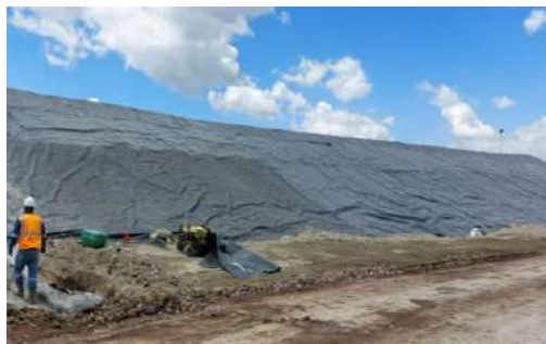
Ilustración 6. Instalación de geomembrana
