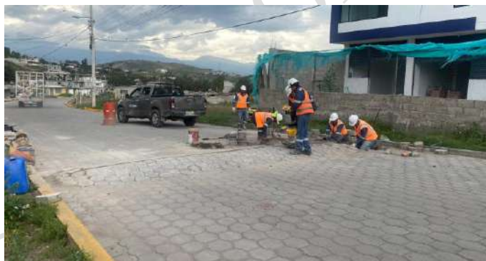
Ilustración 8 Construcción de Vías RS “El Inga”
