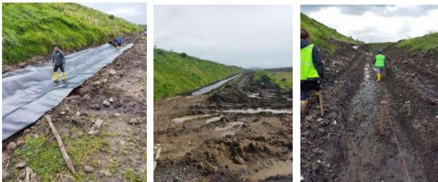
Ilustración 16. Construcción del sistema de drenaje
