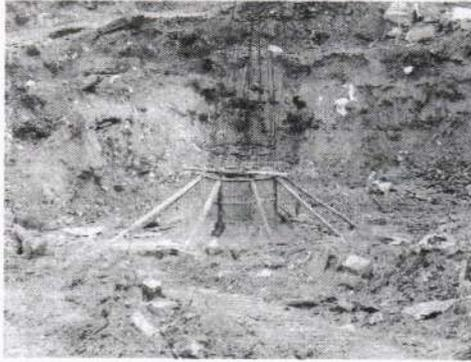
Fotografía a. Construcción de pozos de revisión
