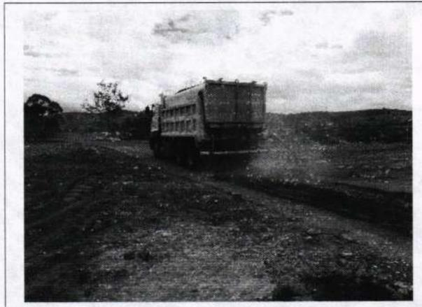
Para el buen estado de las vías de acceso de la escombrera se realizaba mantenimiento mediante una motoniveladora y colocación de material escombros limpio y/o piedra coco, luego este material era compactado (Ilustración 5).
