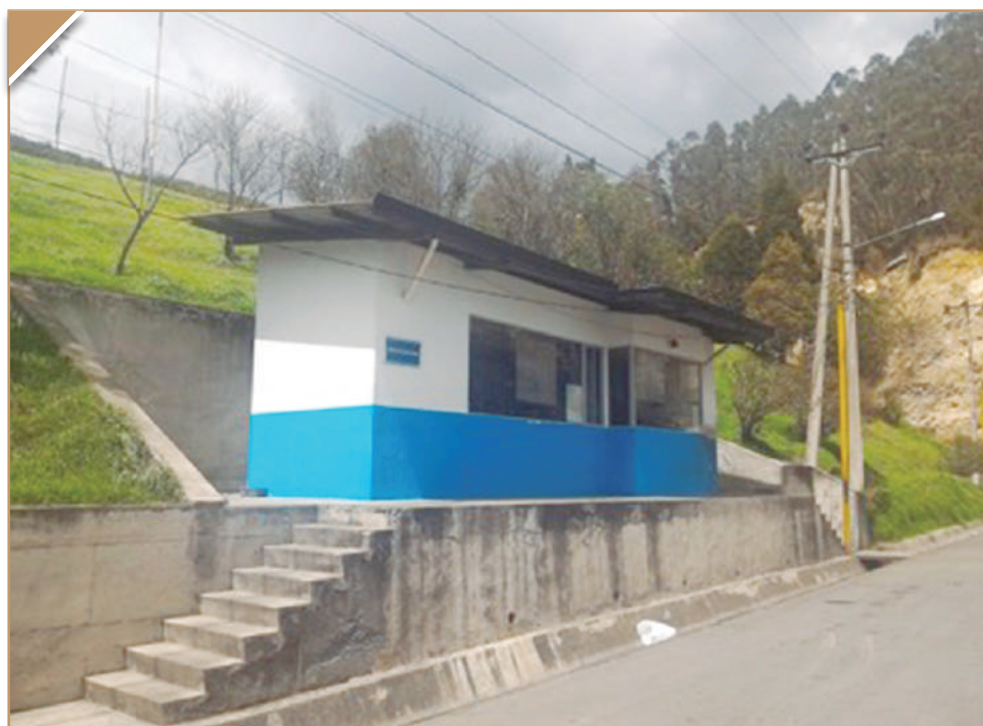
Estación de Pesaje
