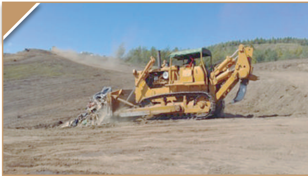
Maquinaria escombrera El Troje 4
