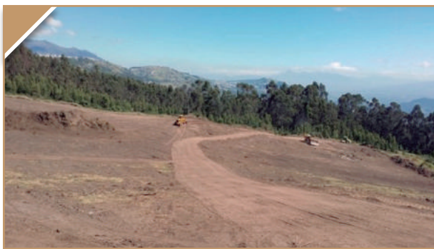
Escombrera El Troje 4
