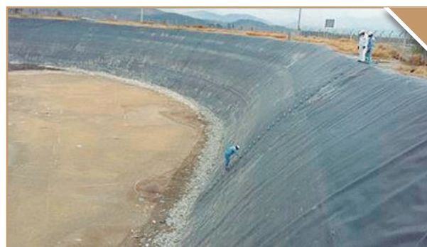
Estado de piscina No. 21 a diciembre del 2015
