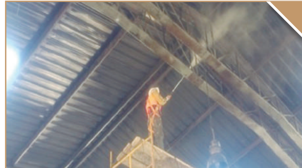
Trabajos en el techo de los hangares de la ET Norte
