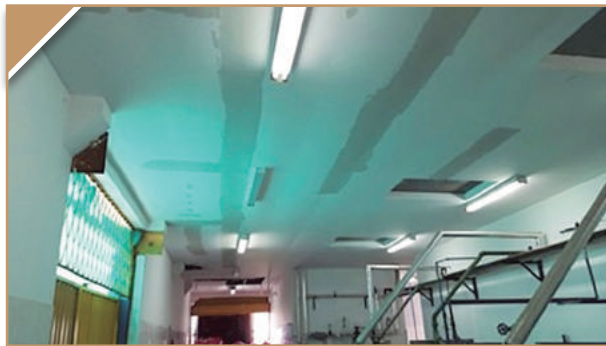
Mantenimiento del techo interno
