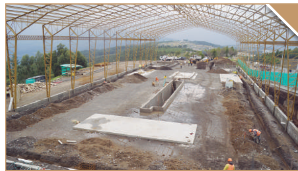
Ejecución de la obra civil
