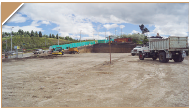
Adecuación del espacio para construir la planta
