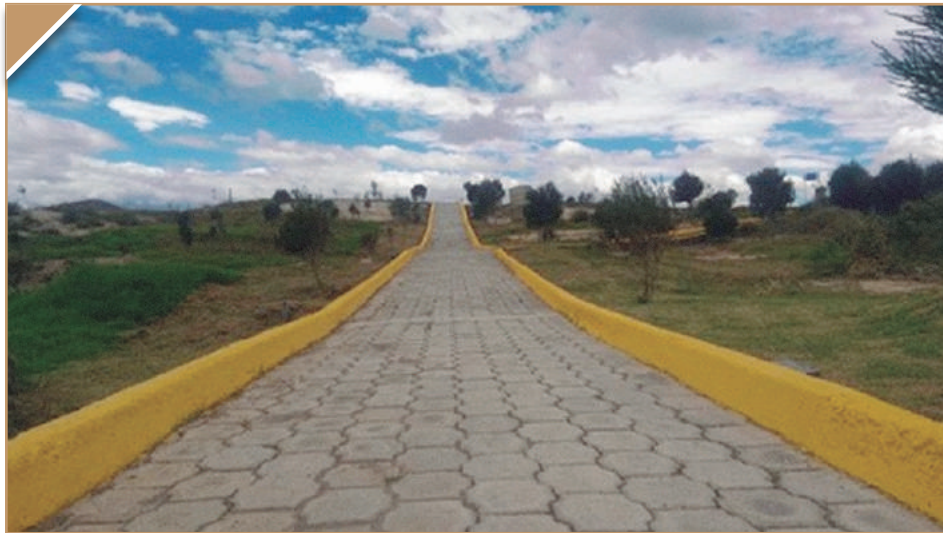
Pintura de bordillos de camineras
