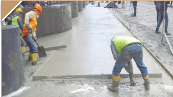
Fundición de losas en hangares de la ET Norte
