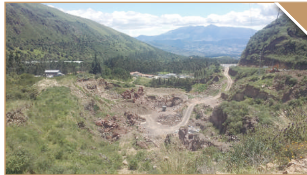
Ingreso escombrera Piedras Negras
