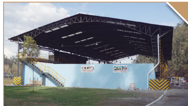
Pintura de la fachada de los hangares de la ET Norte
