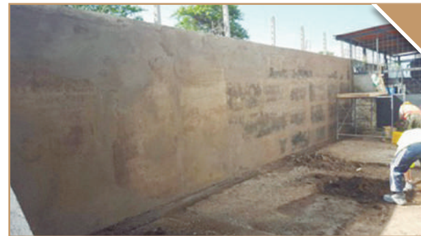
Construcción de bodegas
