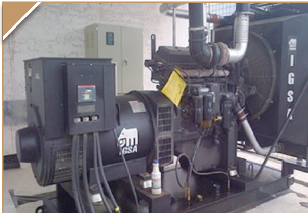
Mantenimiento de generador
