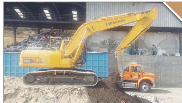
Excavadora trabajando en la ET Norte
