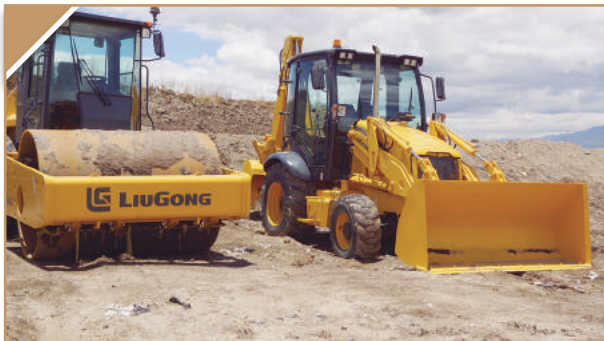
Rodillo y cargadora frontal para disposición de residuos
