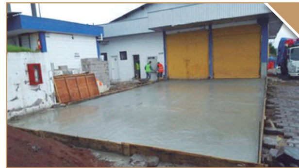
Trabajos en área externa
