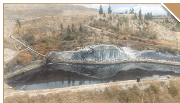
Reducción significativa de los niveles de líquidos lixiviados en el Relleno Sanitario de Quito - Piscina No.09
