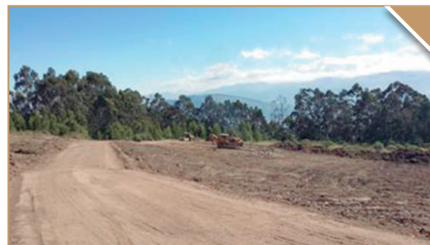
Acceso escombrera El Troje 4
